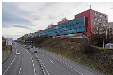
Vom siebenteiligen Bürobau zwischen Nussbaumstrasse und Autobahn ist ein Gebäude zur Zwischennutzung ausgeschrieben. Foto: Raphael Moser
